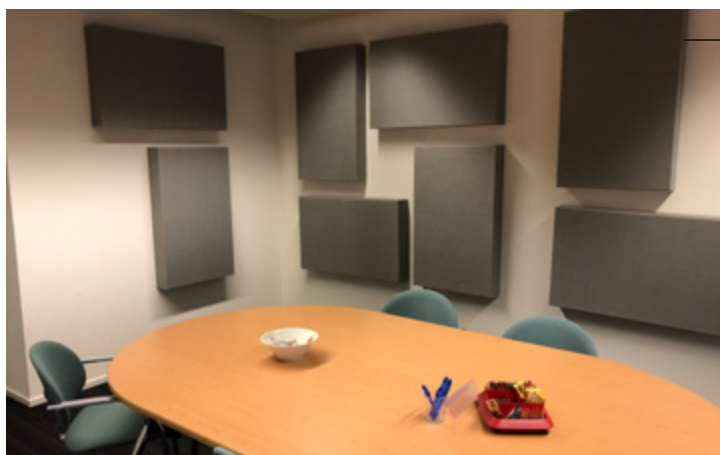
Foto 3: Akoestiek in vergaderruimte door plafond, wandpanelen en tapijt.
