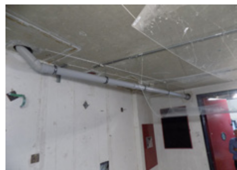
Foto 6: Onderzoek horizontale afvoerleidingen
