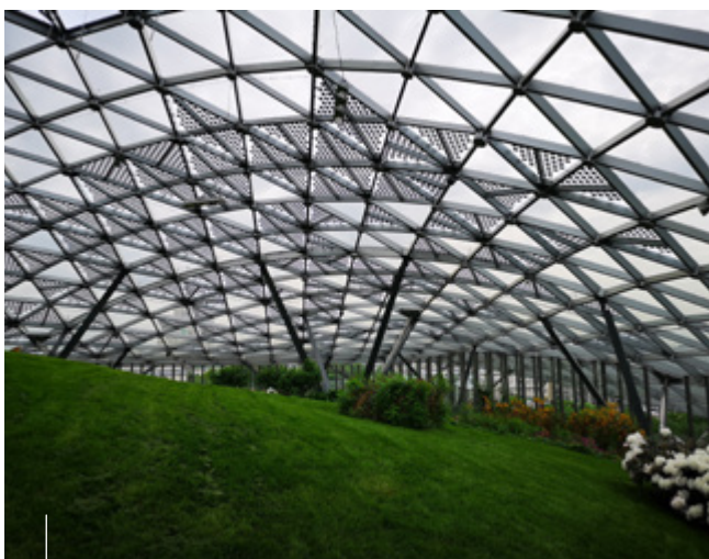
Foto 6 en 7: Karakteristiek voor Zaryadye muziekgebouw is de losstaande glazen luifel van grofweg 120 bij 60 meter. Deze glazen luifel is gevormd uit een 'grid shell' structuur bestaande uit slanke stalen elementen. Het geheel is bedekt met glasplaten.
