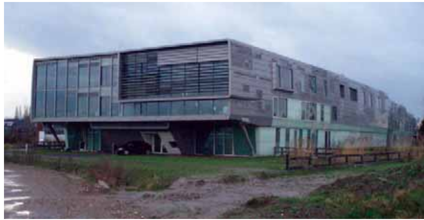
De brede school Forum 't Zand te Utrecht door Venhoeven CS architecten, 2007.
