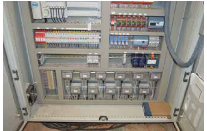
Bij BaOpt/Climotion speelt luchtdruk een grote rol. Die moet daarom goed gemeten worden. Onderin de regelkast zijn de luchtdrukslangetjes te zien. Foto's: Tijd van der Zee
