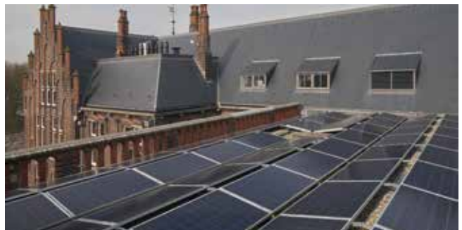
De 100 pv-panelen op het dak van het gebouw zorgen er voor dat de studentenwoningen een energielabel B hebben. Foto: Gerard van Beek
