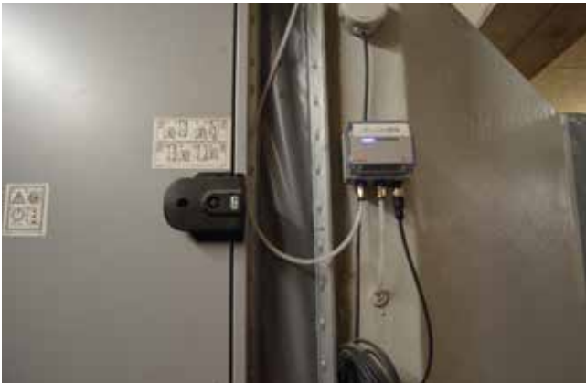
Bij BaOpt/Climotion speelt luchtdruk een grote rol. Die moet daarom goed gemeten worden. Onderin de regelkast zijn de luchtdrukslangetjes te zien. Foto's: Tijd van der Zee
