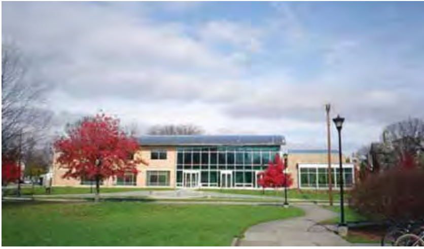
PV arrays op het dak van het Lewis Center van Oberlin College in Oberlin, Ohio.
