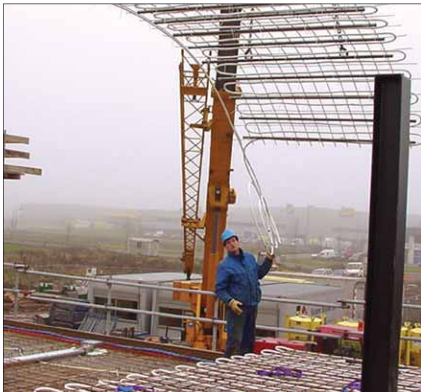
Inhijzen leidingnet in de praktijk (Foto Betonson).
