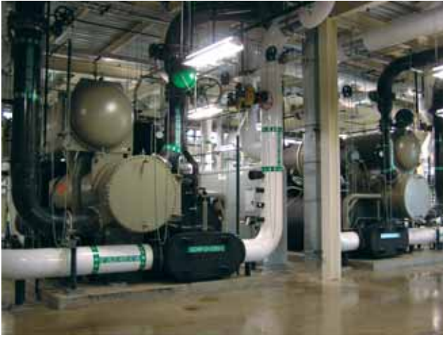
Technische ruimten TI, koelmachines en RO waterbehandeling.
