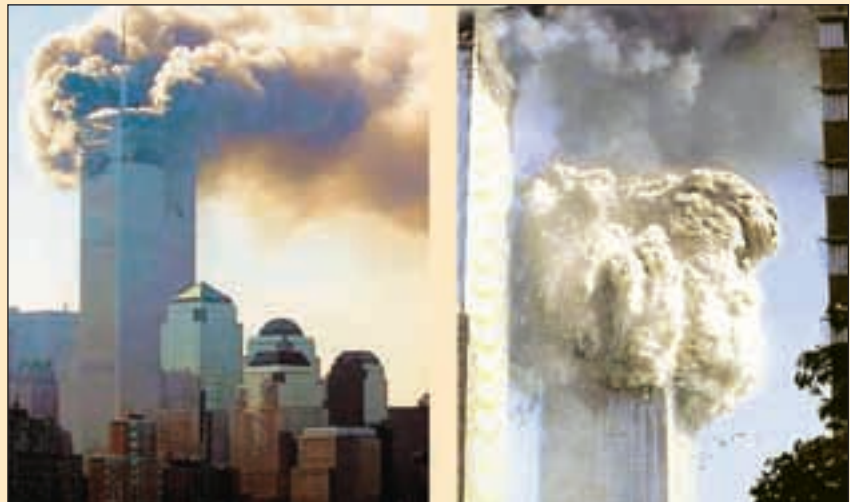
Instorting WTC torens te New York op 11 september 2001. Op de rechter foto is duidelijk te zien, dat de instorting in kettingreactie van boven naar beneden voortschrijdt.
