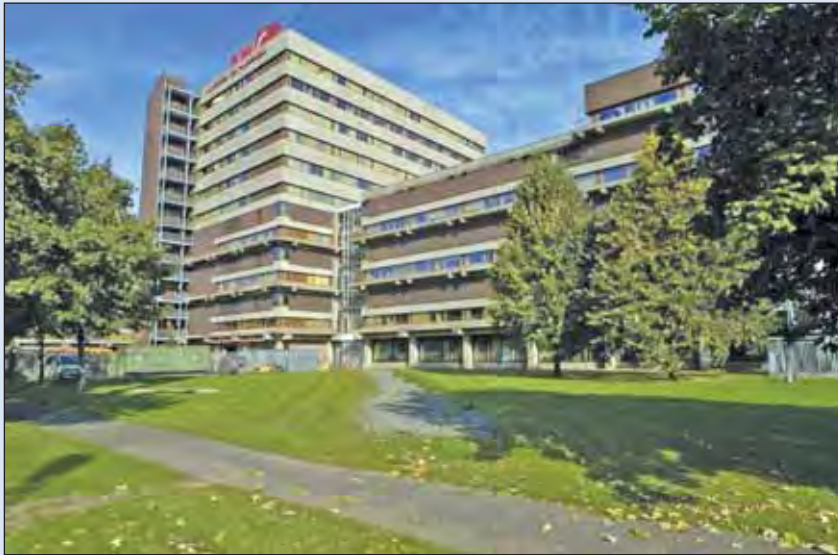
Het AMC te Amsterdam renoveert de energiecentrale.
