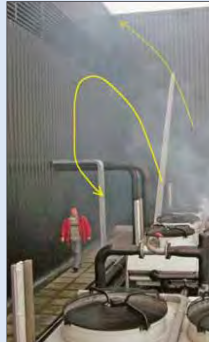
Rookproef dry coolers naast hoge wand.
