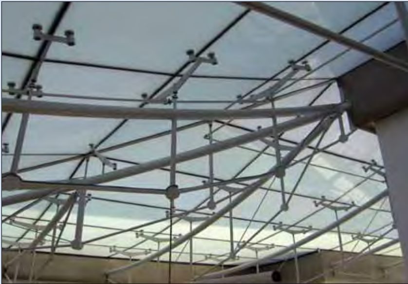
Glazen dak met vakwerkconstructie.
