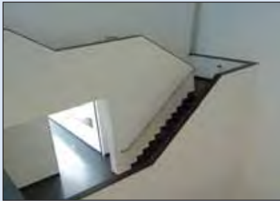
Betonwanden met brandwerende afstrijklaag.
