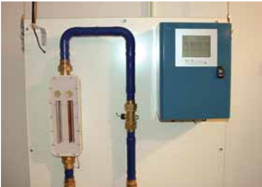
Het ICA-systeem met links de elektrodekamer. Rechts de controlekast.
