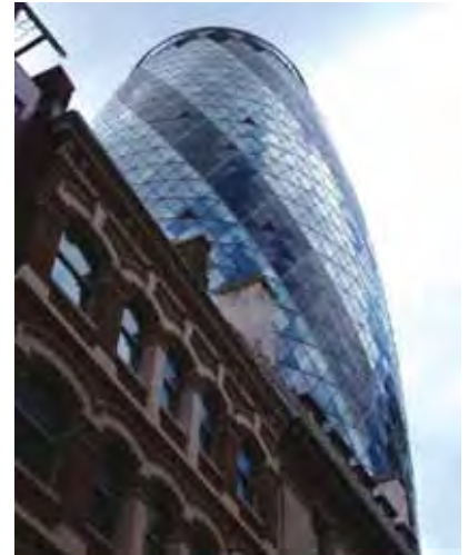
Weergave van een 180 m hoog verzekeringskantoor, het Swiss RE-gebouw in Londen, waarvan een aantal van de driehoekige ramen kunnen worden opgezet om de tweede huid en de atria te kunnen ventileren.
