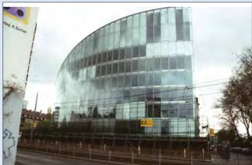
Kantoorgebouw van Norman Foster met een van de eerste tweedehuidgevels. Door het ontbreken van compartimentering ontstonden boven in de spouw dermate hoge temperaturen dat er glaspanelen uit hun rubbers sprongen.
