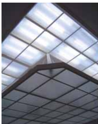
Toepassing van verschillende typen lichtdoorlatende plafonds: fluorescentielampen boven glaspanelen (links) en fluorescentielampen boven spanplafond (rechts).
