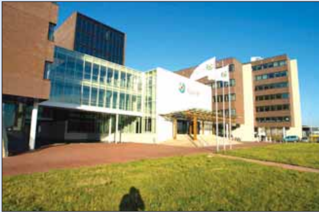
Kantoorgebouw Kluwer te Alphen aan de Rijn waarin een centrale collectieve installatie is gerealiseerd voor meerdere kantoorvleugels. Vanuit een centrale installatie met warmtewisselaars, warmtepomp en ketels wordt koude en warmte gedistribueerd naar de verschillende bouwdelen.
