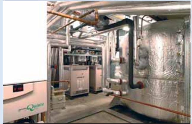
Technische ruimte met buffervat, warmtepompen en ketel voor aansluiting van een appartementengebouw op de collectieve installatie van het zogenaamde 2 MW-project in Haarlem. Op de collectieve energieopslag (warmteopslag) zijn verschillende appartementengebouwen aangesloten met elk een eigen warmtepomp (gecombineerd met ketels en grootschalige toepassing van zonnecollectoren).
