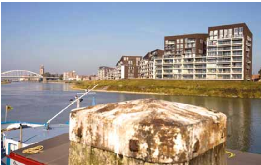
In het appartementencomplex Pothoofd te Deventer is een collectieve installatie gerealiseerd met een centrale warmtewisselaar, warmtepomp, wkk en ketels. Vanuit de centrale installatie wordt warmte en ook koude gedistribueerd naar de appartementen.
