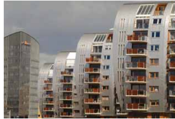
Kantoor en appartementen die zijn aangesloten op collectieve installatie Paleiskwartier 's-Hertogenbosch. Naast deze gebouwen zijn meerdere gebouwen aangesloten op de collectieve installatie. Bij deze collectieve installatie wordt grondwater gedistribueerd door een zogenaamd vierpijps-distributiesysteem. Per gebouw of cluster gebouwen is een aansluiting gerealiseerd die bestaat uit een warmtewisselaar, een warmtepomp en ketels.
