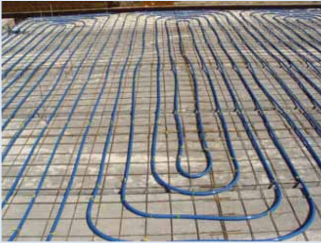
Watervoerende leidingen die in het werk zijn aangebracht.
