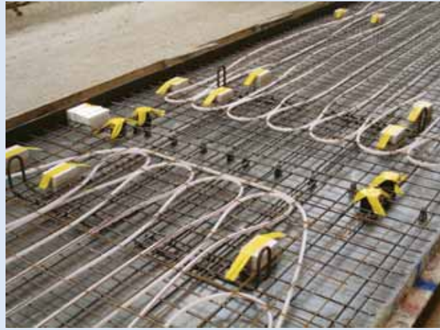
Opname prefab registers in Wingvloerplaat.
