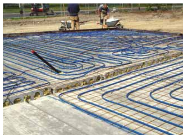
Toepassing BKA in druklaag op kanaalplaatvloeren (in het werk aangebracht).
