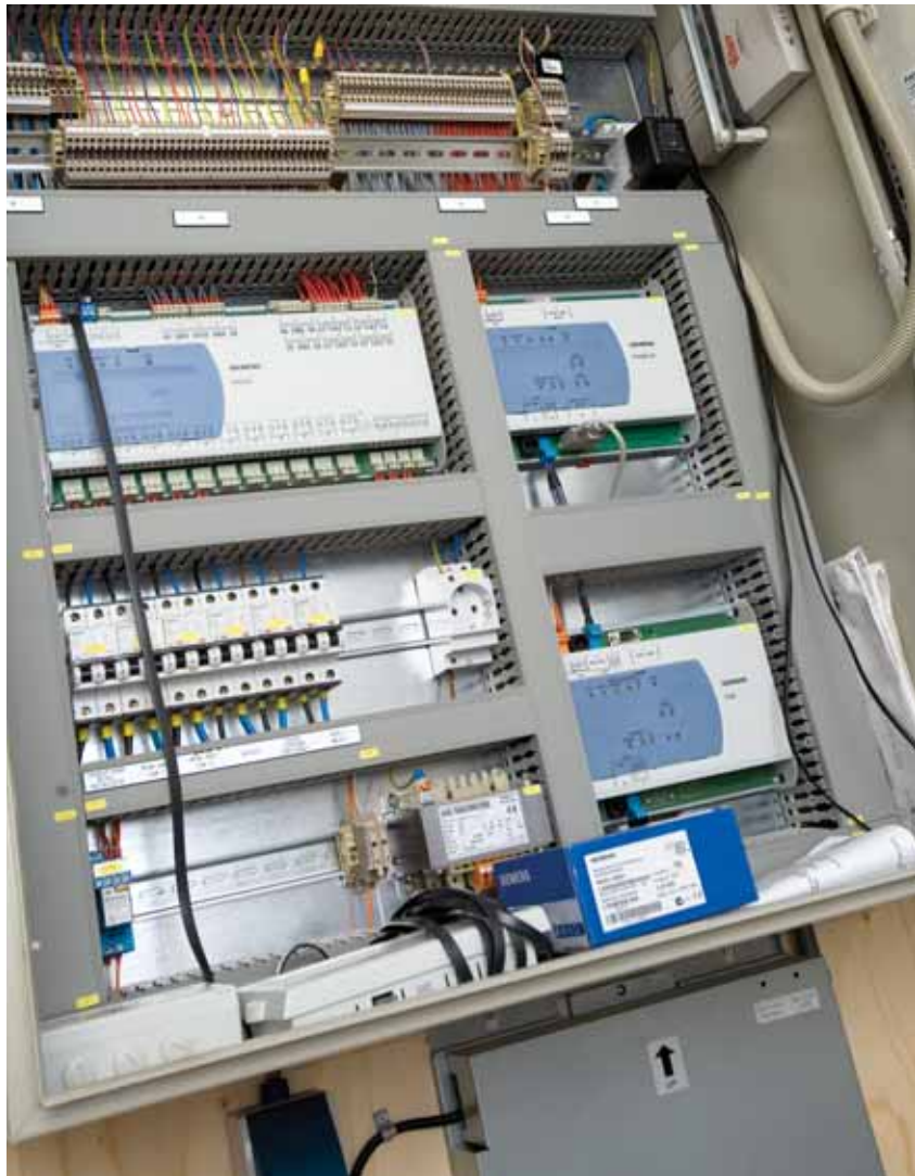
De GBS regelkast met het Desigo RXC regelsysteem en de LMAP overzichtelijk bij elkaar.
