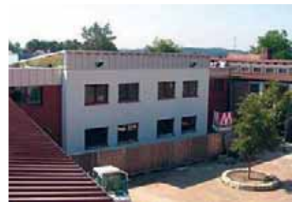
Renovatie bestandsschule in Baiersdorf/Mittelfranken, bron Werner Haase [26].
