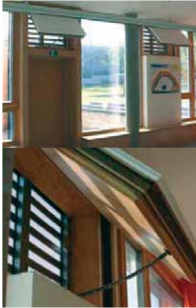
Zomer ventilatiekleppen (twee stuks per klaslokaal) in wijd geopende toestand [11].
