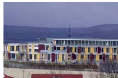
Passiefhuis school Frankfurt Riedberg, bron Architektenbüro 4a (Stuttgart) [10].
