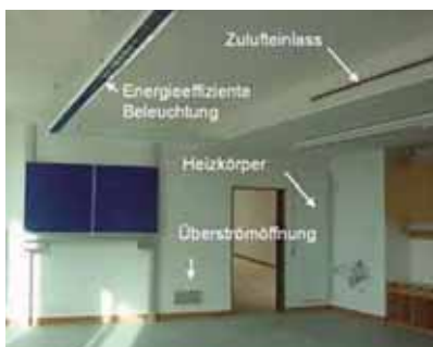
Componenten van de verwarmings- en ventilatievoorzieningen in een nog leeg lokaal [11].
