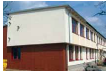
Renovatie bestandsschule in Baiersdorf/Mittelfranken, bron Werner Haase [25].
