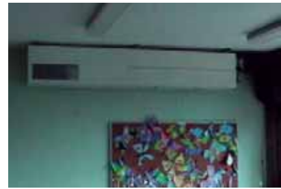
Plaatsing decentrale ventilatie-units in de klaslokalen [20].
