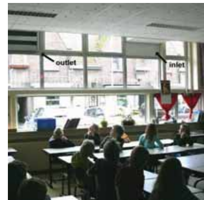
Frissescholen-concept met decentrale toe- en afvoer via de gevel.
