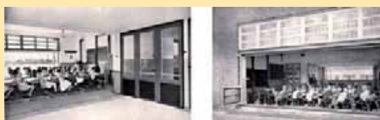
St.Nicolaasschool, interieur, situatie: geopende ramen en scheidingswanden verplaatst naar een stand dwars op de gang [8].
