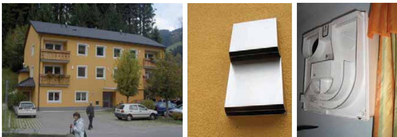
Voorbeeld van een renovatieproject te Gazen, Oostenrijk, toepassing van decentrale ventilatie-eenheid met warmteterugwinning (per ruimte). Links: gebouw van 22 appartementen na renovatie naar passiefhuis-standaard, rechts boven: zicht op de decentrale ventilatie-units buiten, rechts beneden: zicht binnen onder afdekkap decentrale ventilatie met warmteterugwinning. (Foto's: E. Mlecnik)
