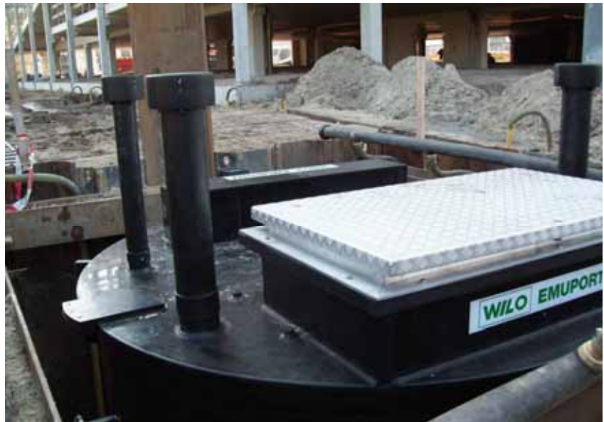
Plaatsing ABC®-system in de grond.
