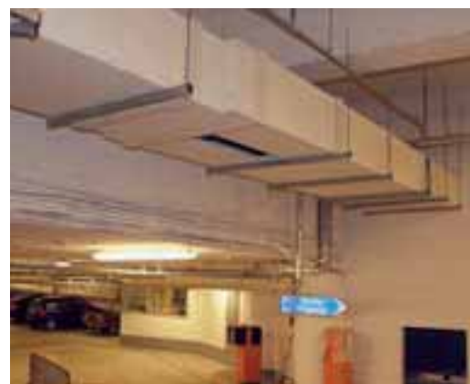
Voorbeeld bekleed ventilatiekanaal ( bron Promat).
