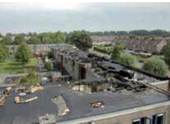
Onvoldoende brandwerende woningscheiding leidt tot uitbranden meerdere woningen (bron foto: VROM-inspectiesignaal').
