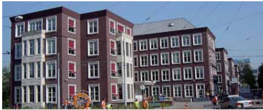
Een voorbeeld van de onderzochte ING panden.
