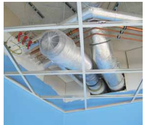
Afgesloten kanaaleind tijdens de bouw.
