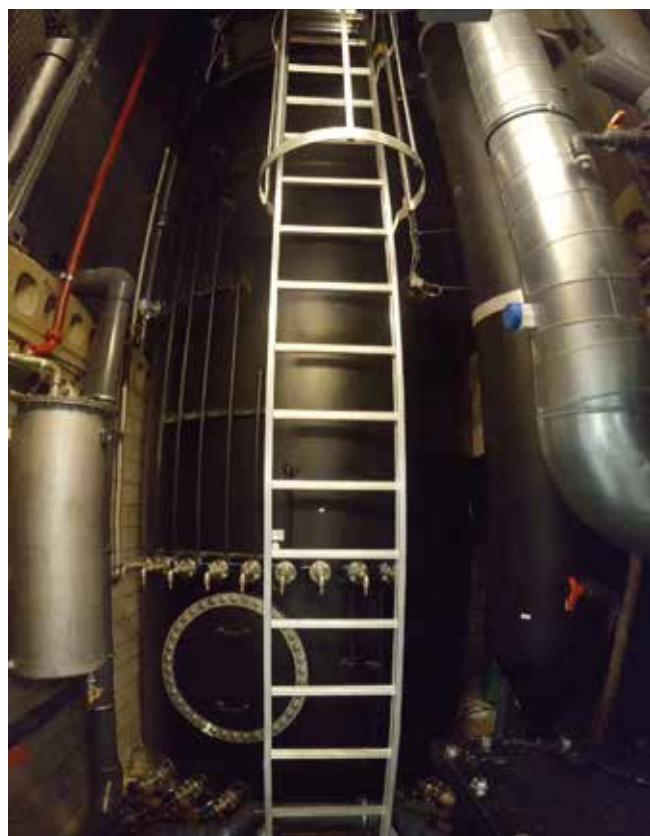
Figuur 4. De grote vergistingstank staat in de kelderhoek van het pand aan de Rijnstraat. Hij is zo groot dat hij twee verdiepingen beslaat.
