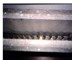
Voorbeeld van een extreem vervuilde inductie-unit. Op de linkerfoto is de unit geheel bedekt met een stofdeken.
