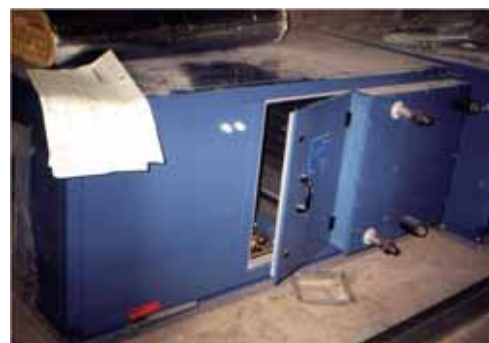
Voorbeelden van installeren met vervuilde componenten.
