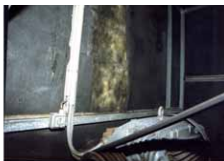
Voorbeeld van een extreem vervuilde luchtbehandelingskast.
