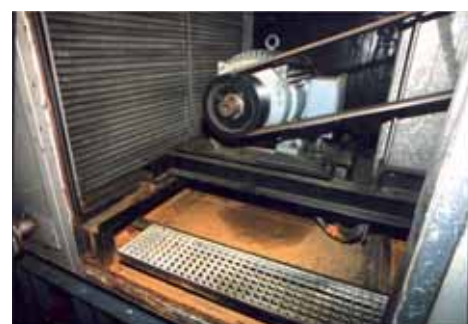
Voorbeeld van een extreem vervuilde luchtbehandelingskast.
