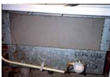
Voorbeeld van een extreem vervuilde inductie-unit. Op de linkerfoto is de unit geheel bedekt met een stofdeken.
