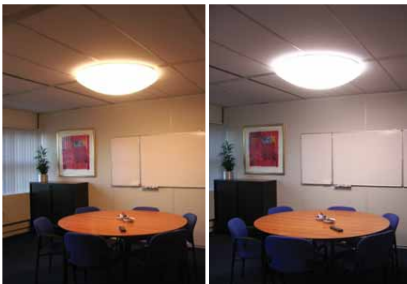
Voorbeeld verlichting waarbij verlichtingsniveau en kleurtemperatuur gedurende de dag kunnen variëren. Het betreft één van de negen proefgebieden bij Grontmij | Technical Management met biodynamische verlichting en verlichting waarbij handmatig niveau en kleurtemperatuur kunnen worden ingesteld.
