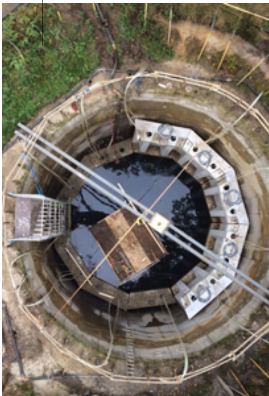
Foto 5: Van boven is goed te zien hoe de elementen aan elkaar worden geklikt.
