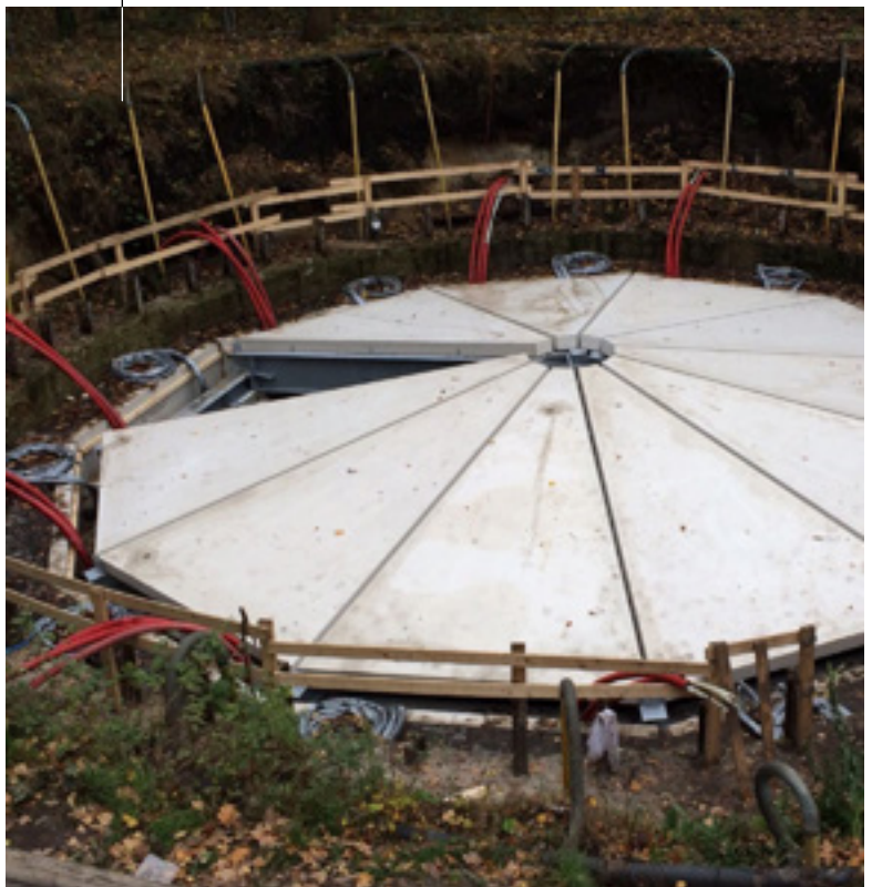
Foto 6: Als het Ecovat van binnen klaar is, wordt het deksel in de vorm van prefab dakelementen er op gelegd. Na verdere isolatie wordt alles afgedekt met zand en is het Ecovat klaar voor gebruik.
