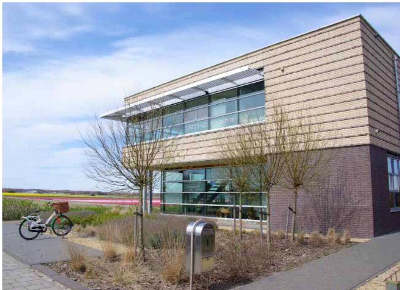
Orthoteam in Julianadorp: orthodontistenpraktijk uit 2007 met hybride ventilatie, betonkernactivering, klimaatplafonds en bodemopslag met warmtepomp. Het ventilatiesysteem met elektronisch gestuurde gevelroosters is inmiddels vervangen door een ander fabricaat.
