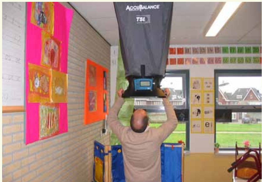
-Figuur 1- Het beoordelen van de ventilatiecapaciteit door het meten van de luchthoeveelheden van een inblaasvoorziening
