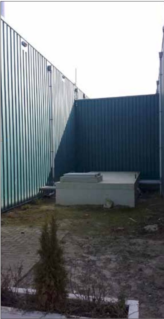
-Figuur 8- Ondergrondse bufferkelder
