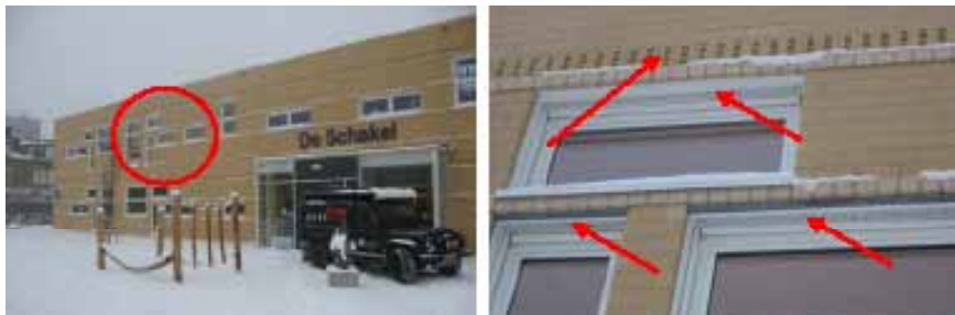
-Figuur 6- Aanzicht gevel basisschool en toevoeropeningen in buitenblad
