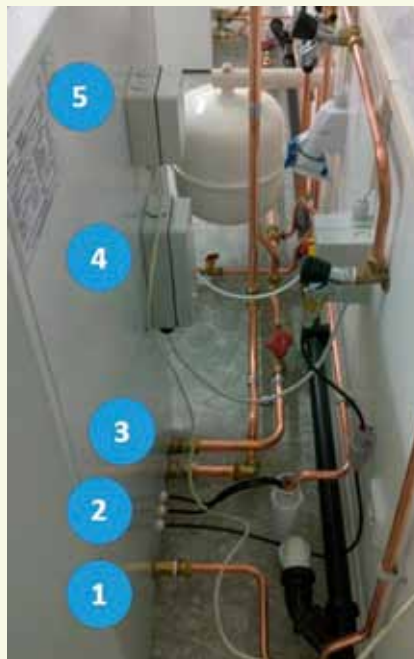
-Foto 2- Een SOFC met de deuren open. De isolatiekast die de eigenlijke brandstofcel bevat is rechts-boven te zien.
