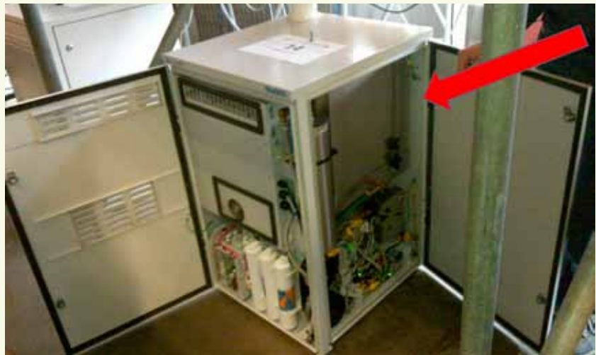
-Foto 2- Een SOFC met de deuren open. De isolatiekast die de eigenlijke brandstofcel bevat is rechts-boven te zien.
