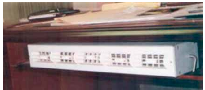
-Figuur 10- Persoonlijk ventilatiesysteem van 'Apacs/Argon Personal Air Control System', geïntegreerd in bureaublad en via een vloerplenum geventileerd. Rechts een foto van het inblaasarmatuur dat onder het bureau geplaatst wordt. Met het systeem is de effectieve temperatuur ('perceived temperature' rekening houdend met luchtsnelheidseffecten) op de individuele werkplek volgens de leverancier in te stellen tussen 18 en 27 °C [11].
