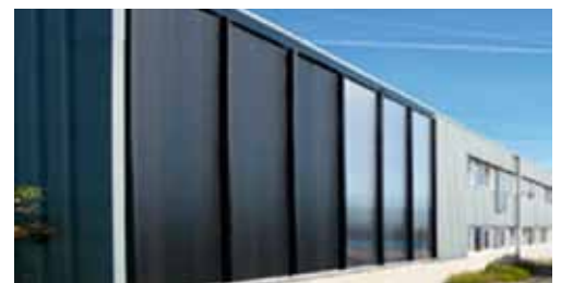
-Figuur 2b- Wand en zonthermische collector in één
