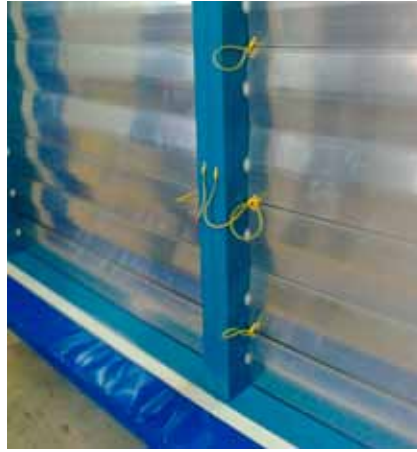
-Figuur 4- Aarding klepbladen door middel van litzes (foto: Harry Bosveld (Deerns))
