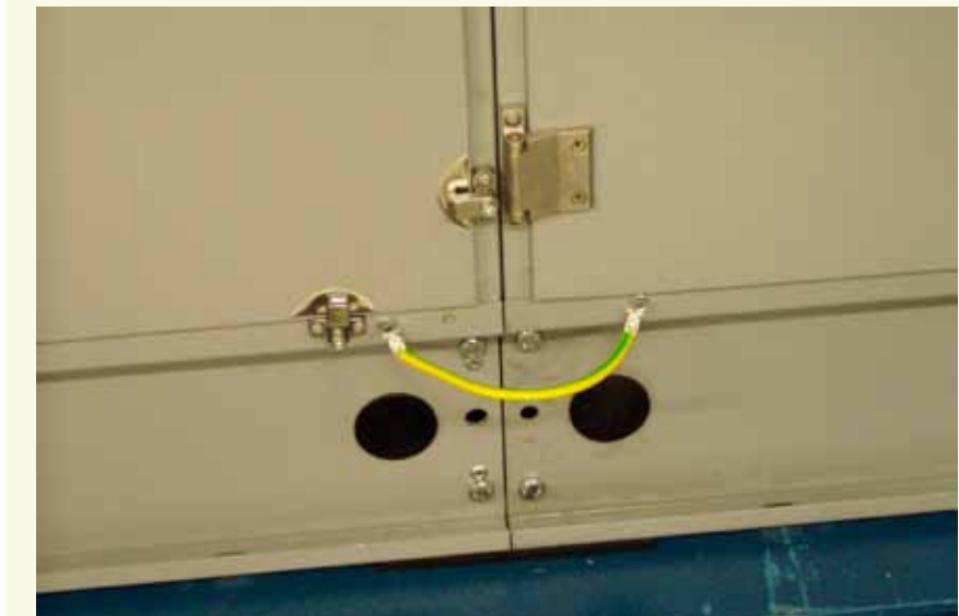
-Figuur 1- Kastdelen worden onderling met een aardedraad verbonden (foto: Harry Bosveld (Deerns))
