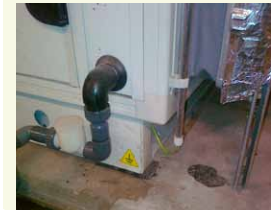
-Figuur 1- Kastdelen worden onderling met een aardedraad verbonden (foto: Harry Bosveld (Deerns))
