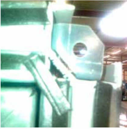
-Figuur 3- Binnen- en buitenpaneel zijn met kunststofblokken en -hoeken van elkaar gescheiden (foto: Harry Bosveld (Deerns))
