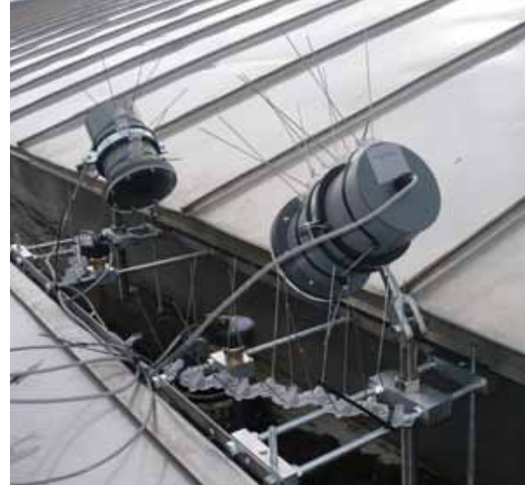
-Figuur 2- Twee camera's op een speciale constructie geïnstalleerd bij een afvoertrechter
