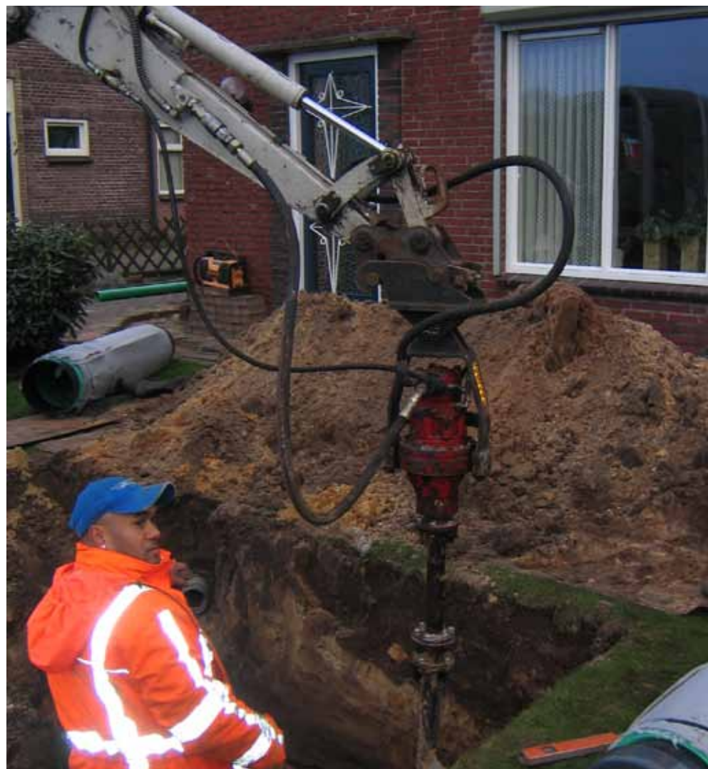
Aanleg verticale infiltratiebuis in Raalte (Foto: gemeente Raalte)
