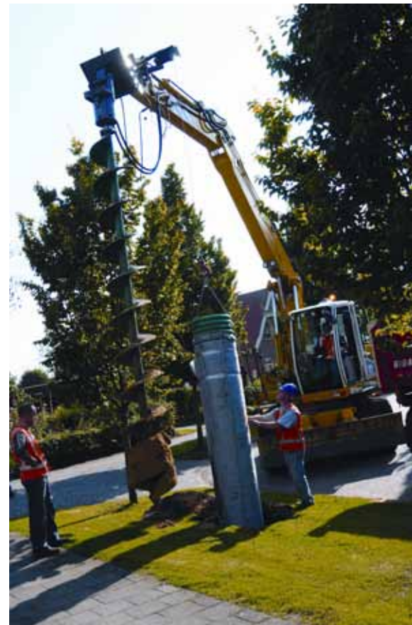
Aanleg verticale infiltratiebuis in Wageningen (Foto: Wavin)
