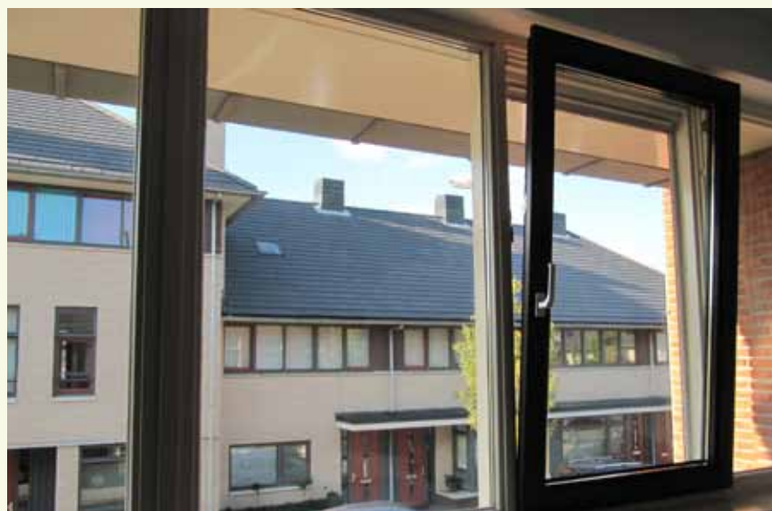
-Figuur 3- Raam in kiepstand goed beschermd onder de overstek
