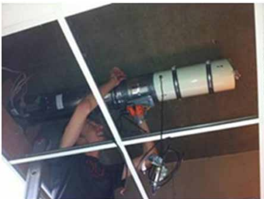
-Figuur 4- Plaatsing van ventilator en filter. Het witte deel is de Aspra luchtreiniger; het filter (met dezelfde diameter als de buis, en een lengte van ~4 cm) wordt in het einde van de buis ingeschoven
