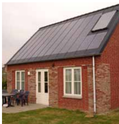
-Figuur 3- Vakantiewoning met pv-systemen (veel opwekking, weinig belasting)
