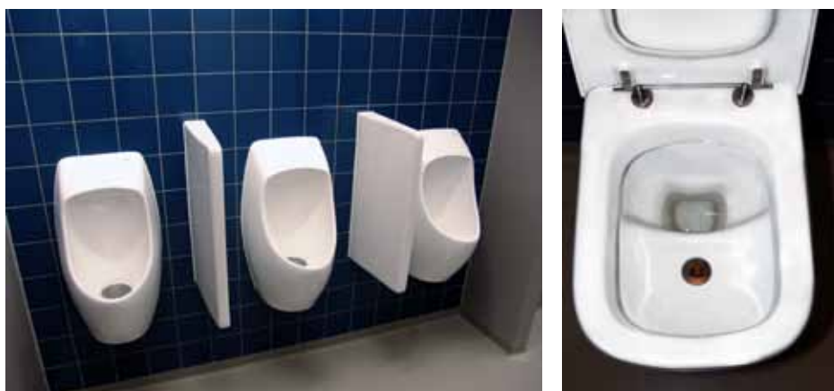
-Figuur 3- Waterloze urinoirs en scheidingstoilet
