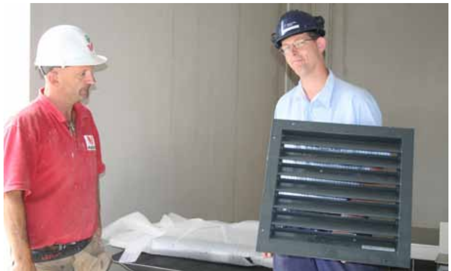
-Figuur 3- Montage luchtrooster voorbereiden op inbouw in samenwerking met de bouwondernemer
