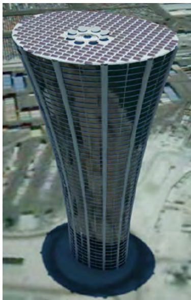
-Figuur 10- Project Burj al Shams, waar een zonnesclootsteen is toegepast voor het afvoeren van ventilatielucht [9, 10]
