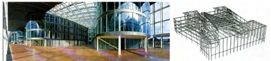
-Figuur 8- Project Rijkswaterstaat Utrecht waarin de staalconstructie van de Atria gedeeltelijk als luchtkanaal fungeert [8]
