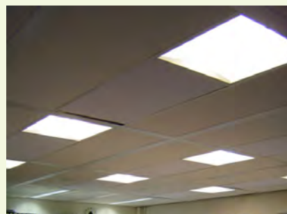
Locaties 2 e verdieping met links verlichtingssysteem van Zumtobel (biodynamische regeling) en rechts van Etap (twee locaties met biodynamische lichtregeling met verschillende instellingen)
