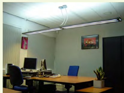
Locaties begane grond met verlichtingssystemen van Trilux (links biodynamisch lichtregeling, rechts handbediening)
