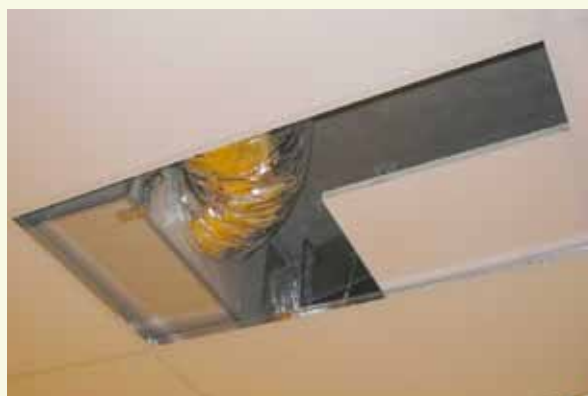
-Figuur 4- Ned-Air VHR600 monoline (WTW klasse-unit), in bouwkundige kast, binnen schoollokaal
