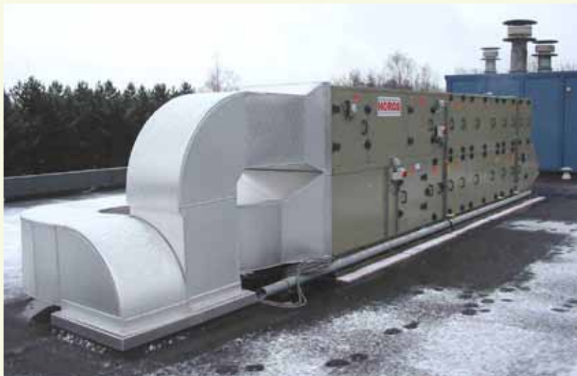
-Figuur 1- Centrale luchtbehandelingskast
