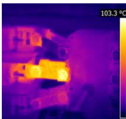
-Foto 1- Met een thermografische camera registreert de inspecteur wat met het blote oog niet waarneembaar is, een temperatuur van 103°C bij de middelste aansluiting. De oorzaak is meestal een sterk gegroeid aantal aangesloten apparaten en machines, zonder dat de installatie hierop is aangepast.
