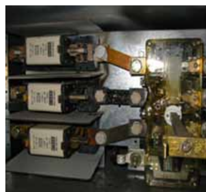
-Foto 1- Met een thermografische camera registreert de inspecteur wat met het blote oog niet waarneembaar is, een temperatuur van 103°C bij de middelste aansluiting. De oorzaak is meestal een sterk gegroeid aantal aangesloten apparaten en machines, zonder dat de installatie hierop is aangepast.
