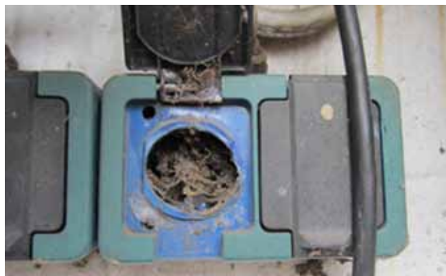
-Foto 2- Als het deksel niet meer sluit hebben spinnen en stof vrij spel met mogelijke oververhitting en vervolgens brand tot gevolg.
