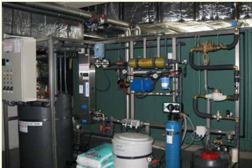
-Foto 2- Terugstroombeveiligingseenheid type BA dekt in deze situatie de gevaren onvoldoende af
