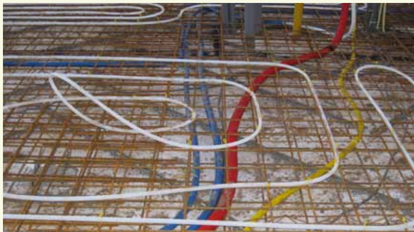
-Foto 1- Opwarming van het drinkwater door vloerverwarmingsleidingen
