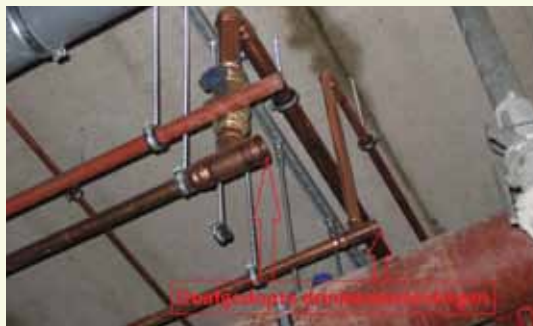
-Foto 2- Terugstroombeveiligingseenheid type BA dekt in deze situatie de gevaren onvoldoende af
